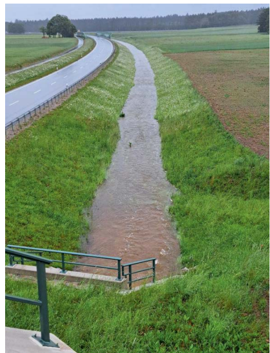
Wasser fließt in der Hochwassermulde Richtung Norden
