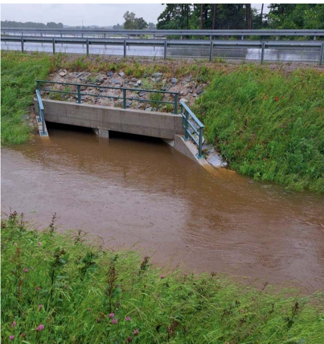
Einleitung des abgesperrten Wehrbachs unter der neuen Ortsumfahrung in die Hochwassermulde
